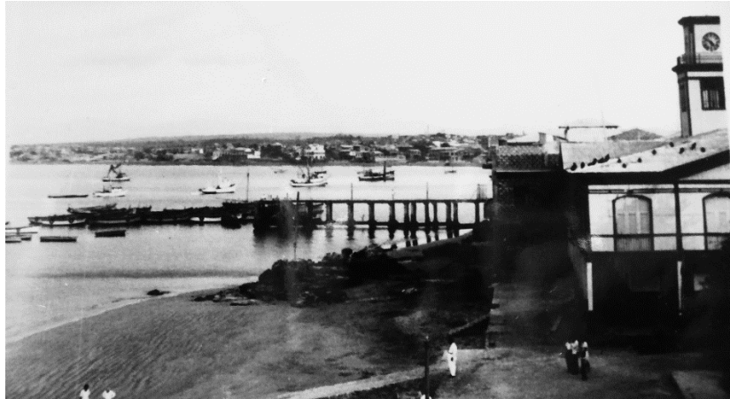
Imagen 17 – construcción del muelle Fuente: investigación Elaborado por: investigador
