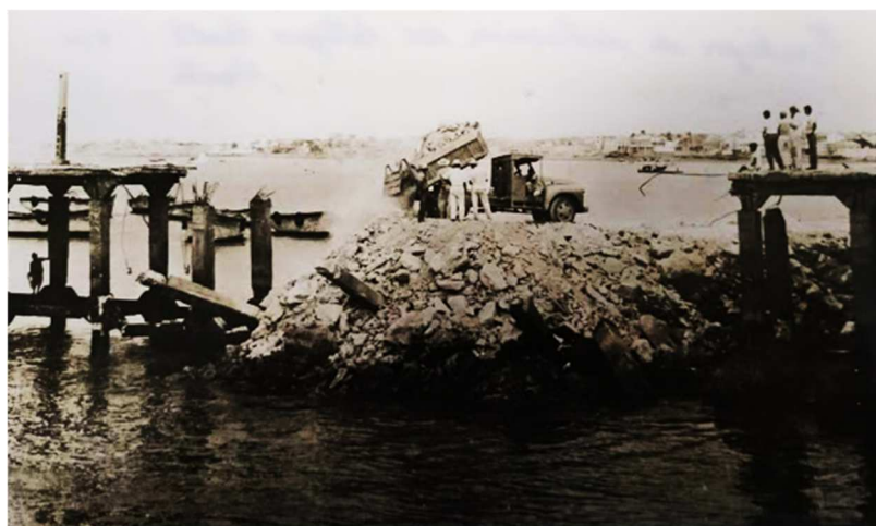
Imagen 19 – materiales para la construcción del muelle Fuente: investigación Elaborado por: investigador
