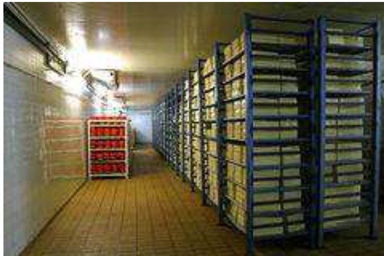
Almacenamiento del queso en cámaras de frío
