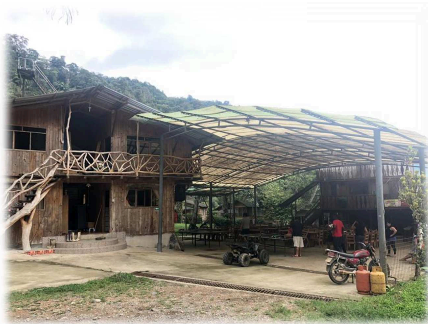
Figura 23 Vista parcial de Mindo Bonito. Fuente: Elaborada por el autor.
