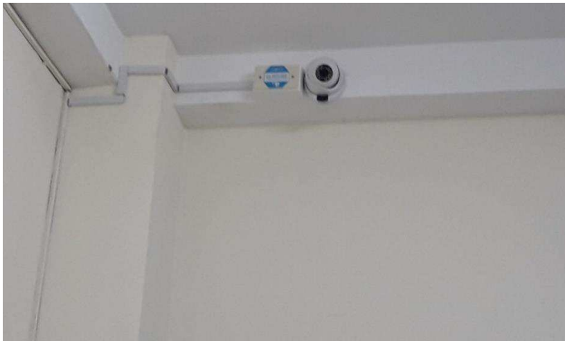
Ilustración 83: Instalación de cámara laboratorio de electrónica
