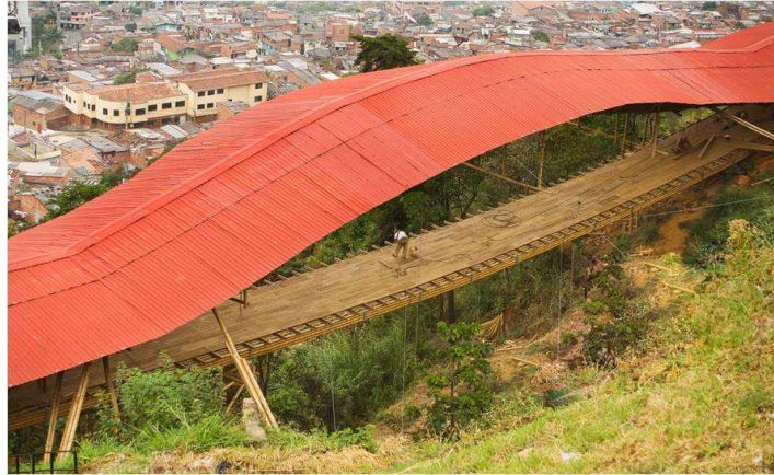
Figura 4. Puente de guadua en Medellín Fuente: Gaviria, 2010
