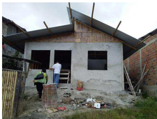
Figura 11. Fachada frontal de la casa con caña guadua - 24 de Mayo Fuente: Los Autores
