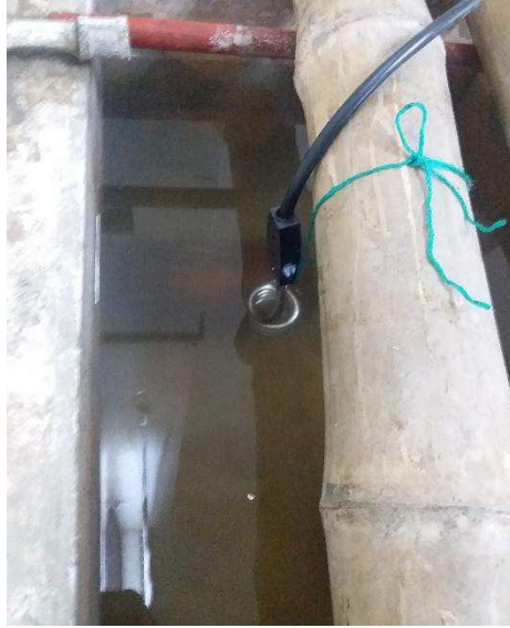
Figura 31. Aplicación de la resistencia eléctrica para calentar el agua Fuente: Los Autores
