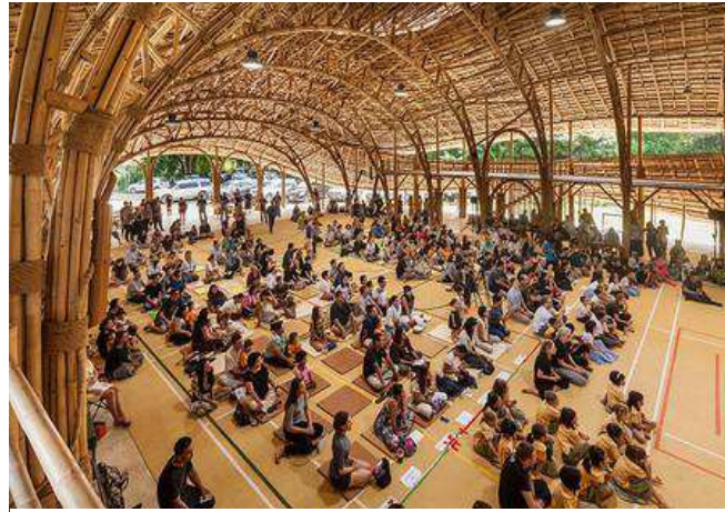
Figura 1. Pabellón deportivo. Fuente: Chiangmai Life Architects
