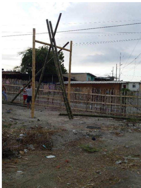
Figura 43. Colocación de las cañas en el caballete Fuente: Los Autores
