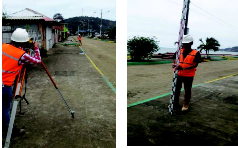
Foto 4 - Levantamiento realizado el 29 de septiembre del 2019 Fuente: Autores
