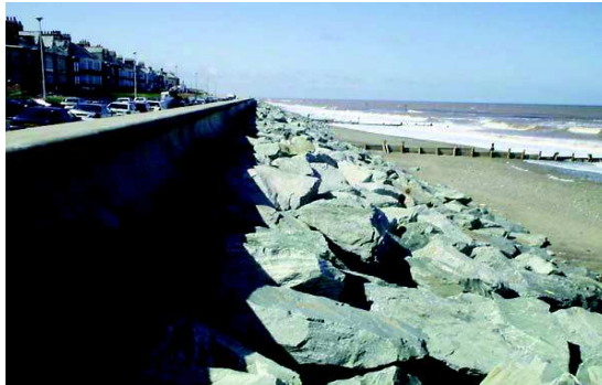
Figura 1 - Malecón con muro escollera Fuente: Imagen de Google
