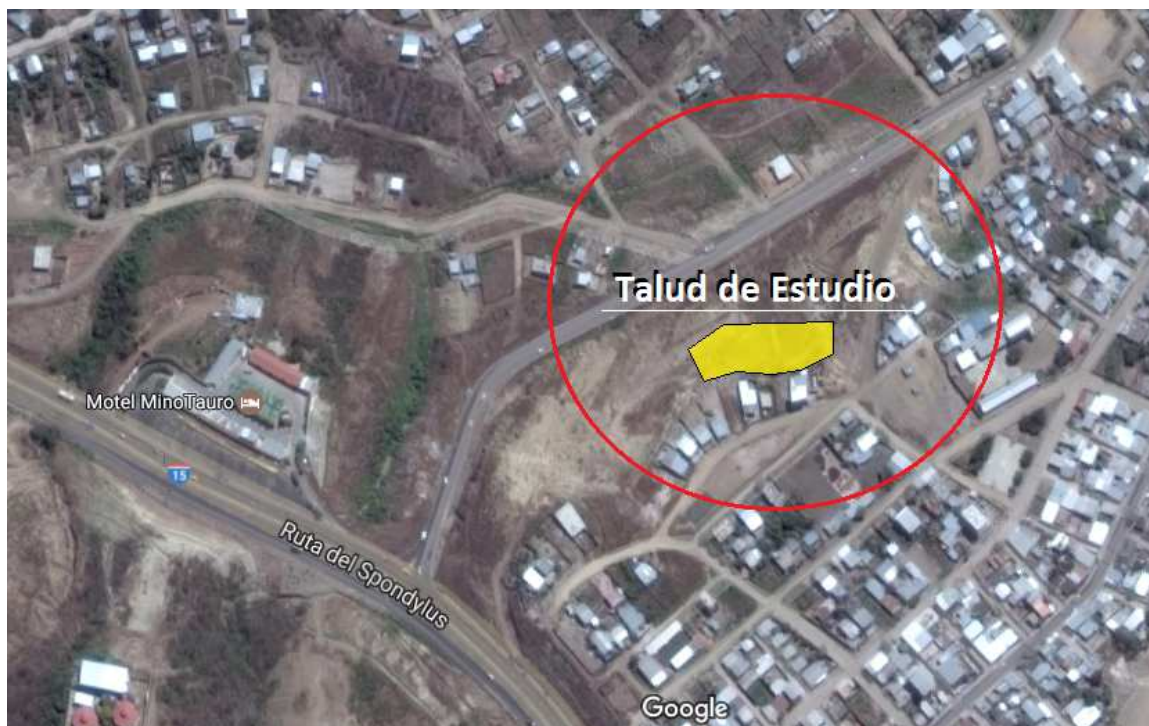
Ilustración 1 Imagen del Talud de Estudio
