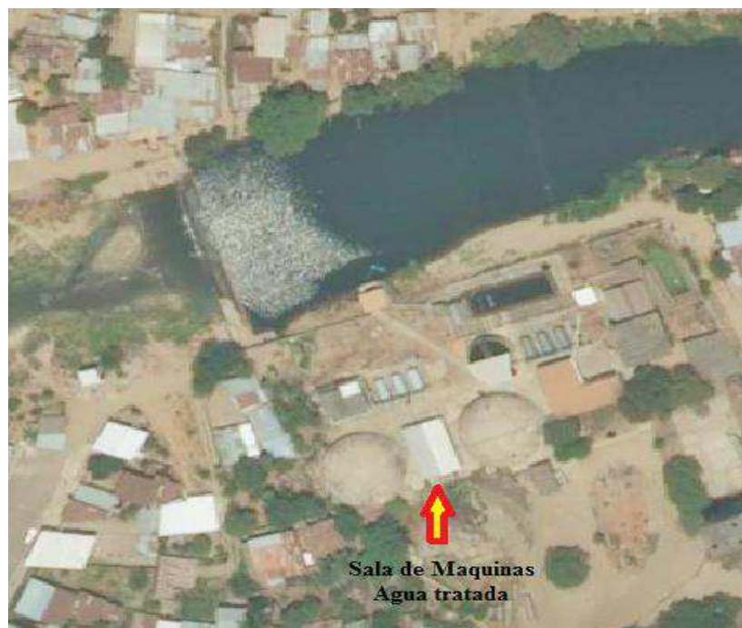
Figura 3.5: Sala de máquinas de aguas tratada.
