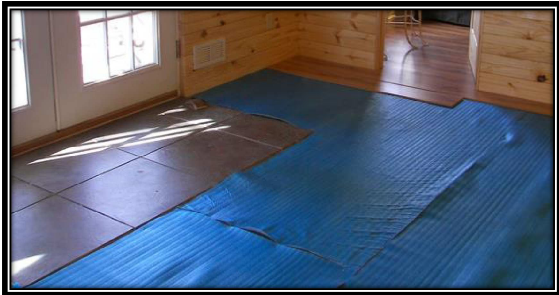
Figura N°3.- instalación de pisos en un contenedor.
