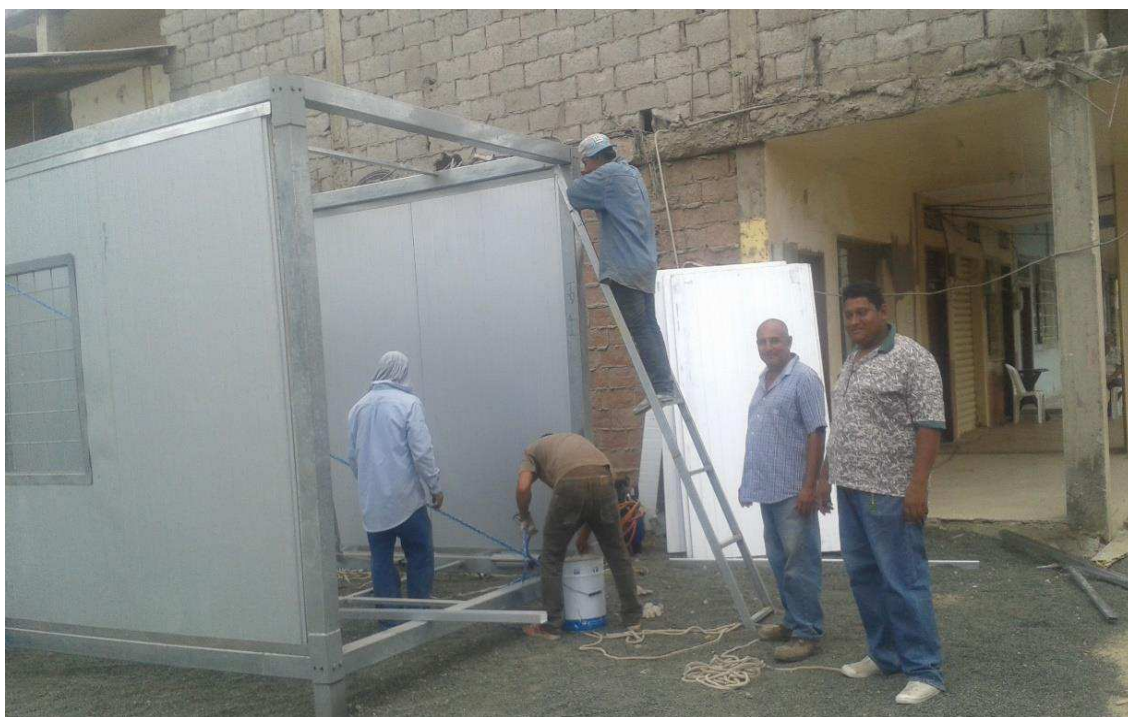
Fotos: Visita realizada a la construccion de una vivienda.
