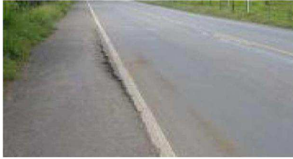
Figura 28. Descenso de la berma.
