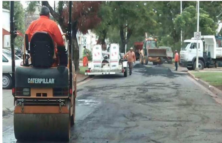
Figura 5. Reconstrucción de Tramos.
