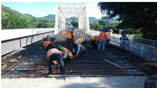
Figura 6. Reconstrucción de puente.
