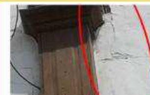
Fig. Fisura
