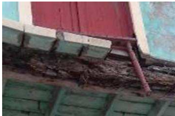
Imagen 10: Pudrición y ataque de insectos en viga
