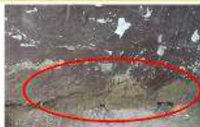
Fig.1 Erosión
