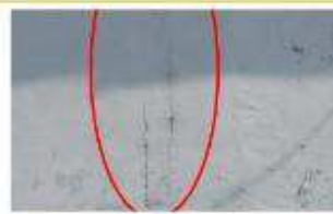
Fig. 2 Fisura
