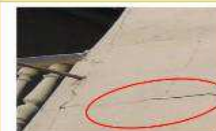
Fig. 2 fisura
