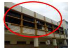
Fig. 6- Derrum. de edif.
