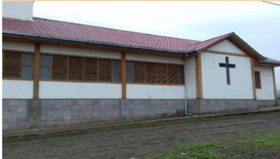
FOTO DE LOS AUTORES DESPUÉS DEL TERREMOTO (2016) FACHADA SECUNDARIA
