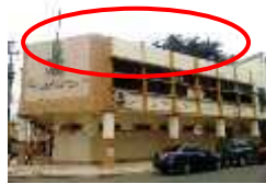
Fig. 5- Derrumbe de edif.
