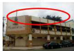
Fig. 5- Derrum. de edif.
