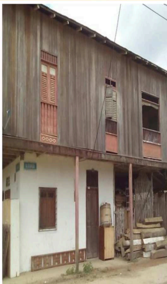
Fig 2. Foto 2da inspección (2016).
