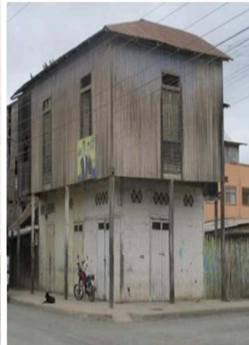
Fig 1. Foto 1ra inspección (2016).
