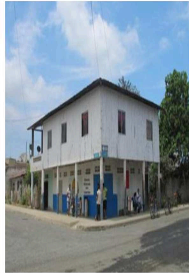
Fig 1. Foto 1ra inspección (2016).
