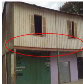
Fig 4. Deformación
