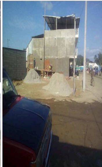
Fig 2. Foto 2da inspección (2016).
