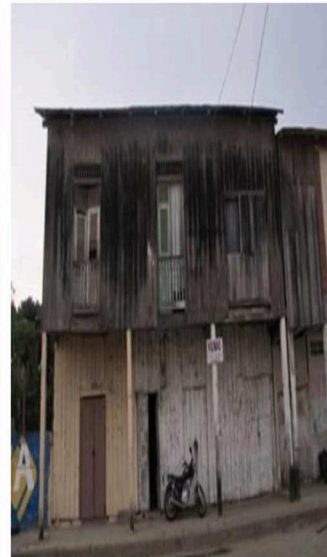
Fig 1. Foto 1ra inspección (2016).
