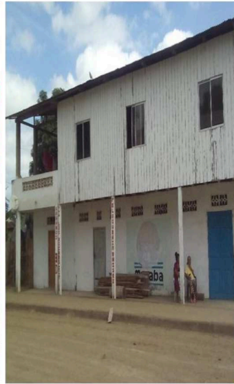
Fig 2. Foto 2da inspección (2016).
