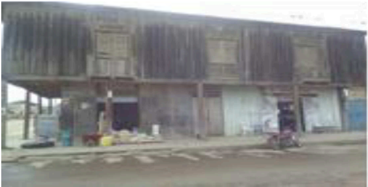
Figura 15. Envejecimiento de la madera. Fuente: Los autores.
