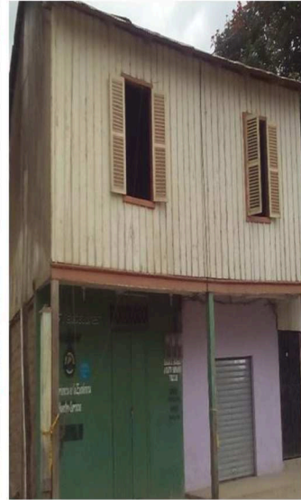
Fig 2. Foto 2da inspección (2016).
