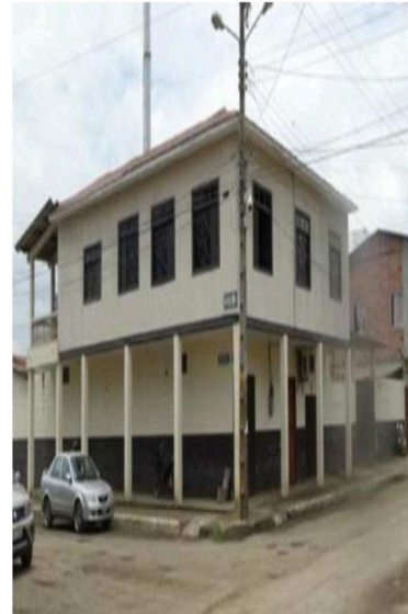
Fig 1. Foto 1ra inspección (2016).
