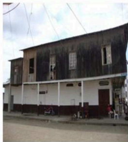
Fig 3. Manchas de humedades
