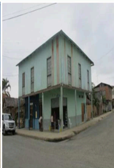
Fig 1. Foto 1ra inspección (2016).
