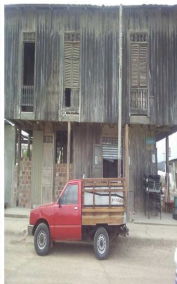
Fig 2. Foto 2da inspección (2016).
