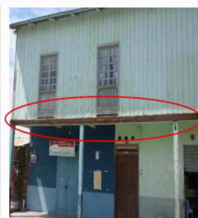
Fig 4. Deformación
