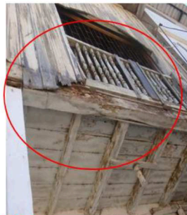
Fig 3. Ataques de insectos a la madera
