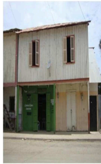
Fig 3. Foto 1ra inspección (2016).
