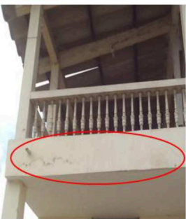
Fig 3. Fisura
