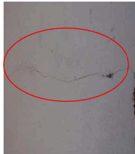
Fig 4. Fisuras
