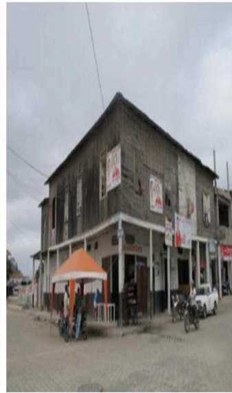
Fig 1. Foto 1ra inspección (2016).
