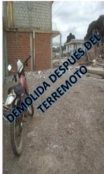
Fig 2. Foto 2da inspección (2016).
