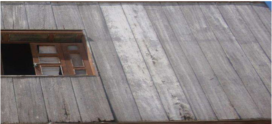
Figura 13. Descascaramiento de la madera. Fuente: Los autores.
