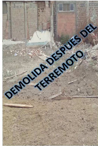
Fig 2. Foto 2da inspección (2016).
