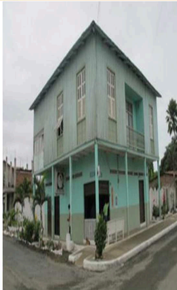
Fig 1. Foto 1ra inspección (2016).
