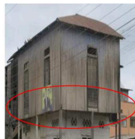
Fig 5. Deformación
