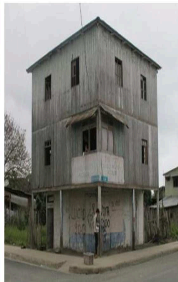
Fig 1. Foto 1ra inspección (2016).
