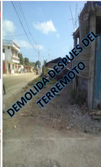
Fig 2. Foto 2da inspección (2016).
