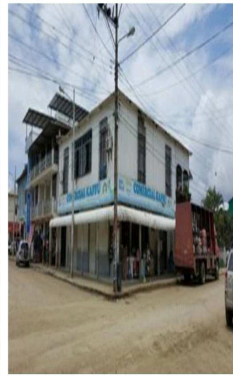
Fig 1. Foto 1ra inspección (2016).
