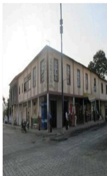
Fig 1. Foto 1ra inspección (2016).
