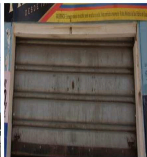
Fig 4. Corrosión
