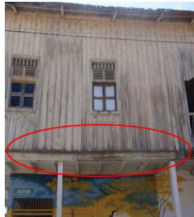
Fig 4. Deformación
