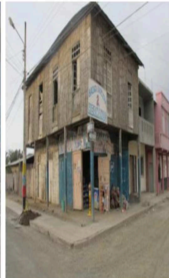
Fig 1. Foto 1ra inspección (2016).
