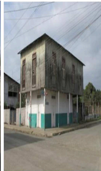
Fig 1. Foto 1ra inspección (2016).
