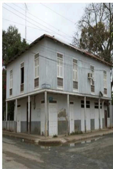
Fig 1. Foto 1ra inspección (2016).
