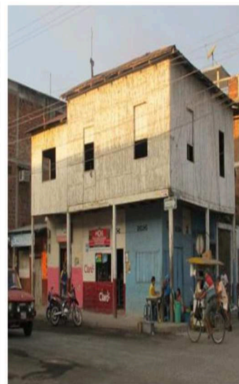
Fig 1. Foto 1ra inspección (2016).
