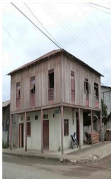
Fig 1. Foto 1ra inspección (2016).
