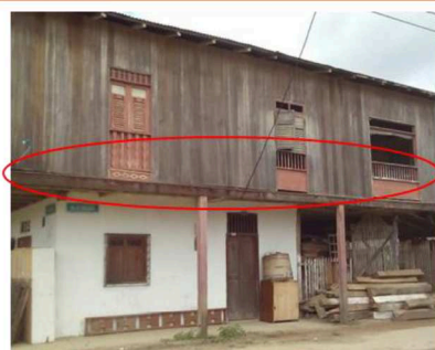
Fig 4. Deformación en la madera
