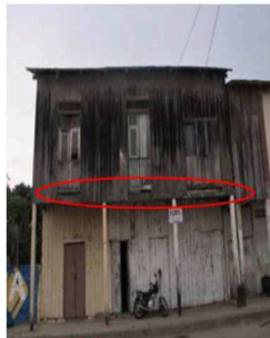
Fig 5. Deformación
