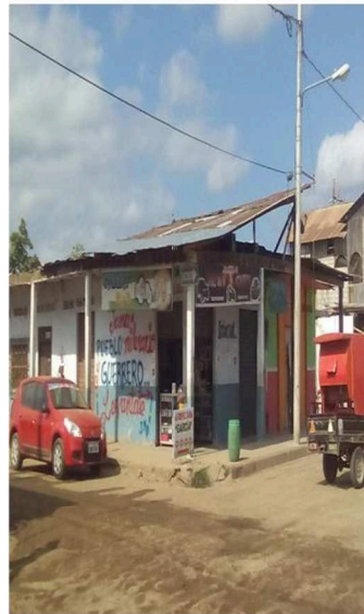
Fig 2. Foto 2da inspección (2016).
