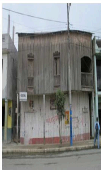
Fig 1. Foto 1ra inspección (2016).
