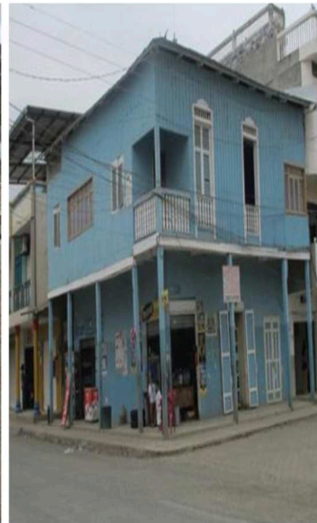
Fig 1. Foto 1ra inspección (2016).
