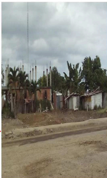
Fig 2. Foto 2da inspección (2016).
