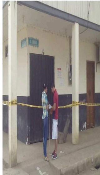
Fig 2. Foto 2da inspección (2016).
