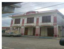
Foto antes del terremoto del 2016
