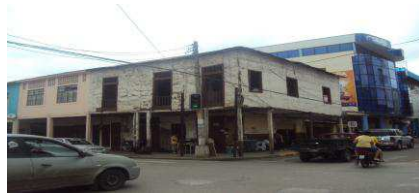
Foto antes del terremoto del 2016
