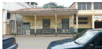
Foto antes del terremoto del 2016
