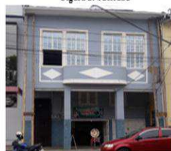
Figura 4: Mal estado de la capa de proteccion
