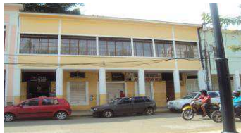
Foto antes del terremoto del 2016
