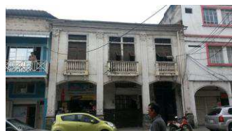
Foto antes del terremoto del 2016
