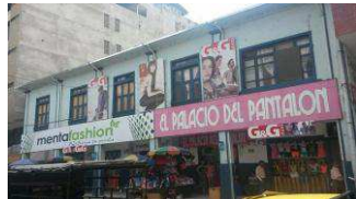
Foto antes del terremoto del 2016
