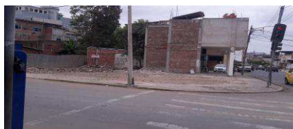
Foto después del terremoto del 2016
