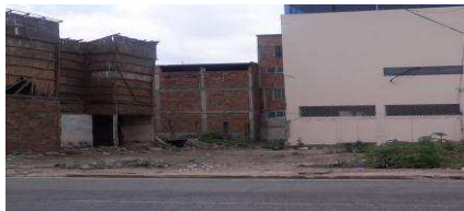
Foto después del terremoto del 2016
