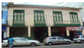
Foto antes del terremoto del 2016
