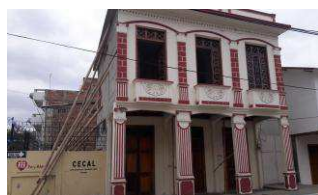
Foto después del terremoto del 2016
