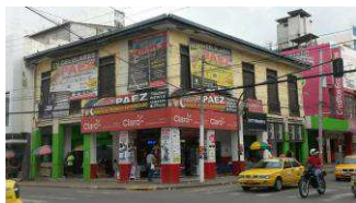
Foto antes del terremoto del 2016
