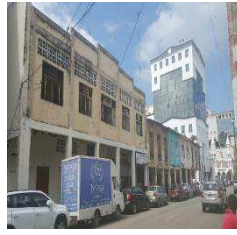
Figura 3: Humedad por capilaridad.
