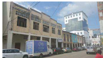
Foto antes del terremoto del 2016
