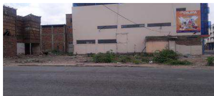
Foto del después del terremoto del 2016
