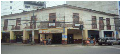
Foto antes del terremoto del 2016
