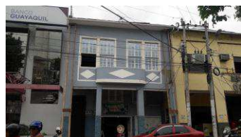
Foto después del terremoto del 2016
