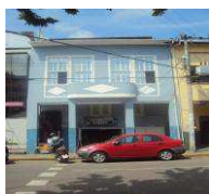
Foto antes del terremoto del 2016
