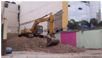
Foto después del terremoto del 2016
