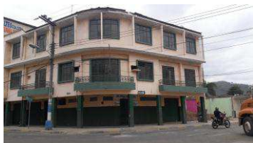
Foto después del terremoto del 2016
