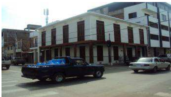
Foto después del terremoto del 2016
