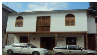
Foto antes del terremoto del 2016
