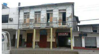
Foto antes del terremoto del 2016
