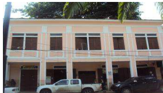
Foto antes del terremoto del 2016
