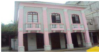
Foto antes del terremoto del 2016
