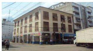
Foto antes del terremoto del 2016
