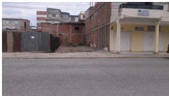
Foto después del terremoto del 2016
