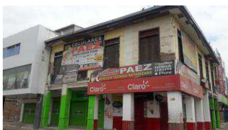
Foto después del terremoto del 2016
