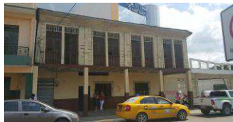
Foto antes del terremoto del 2016
