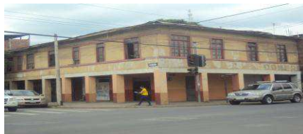
Foto antes del terremoto del 2016
