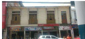
Foto antes del terremoto del 2016
