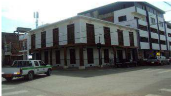
Foto antes del terremoto del 2016
