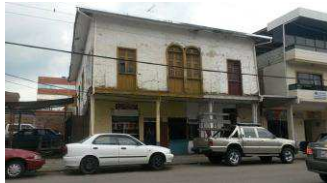
Foto antes del terremoto del 2016
