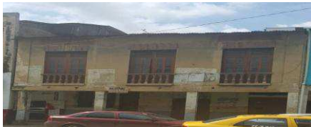
Foto antes del terremoto del 2016
