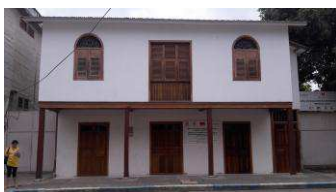
Foto después del terremoto del 2016
