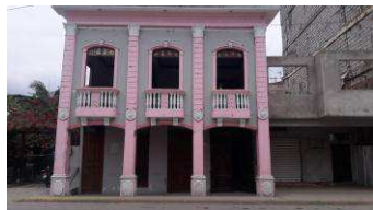
Foto después del terremoto del 2016
