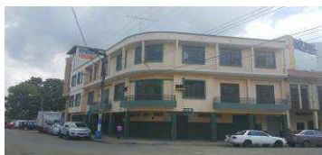
Foto antes del terremoto del 2016
