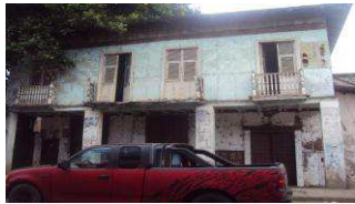
Foto antes del terremoto del 2016
