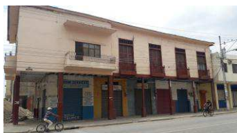
Foto después del terremoto del 2016
