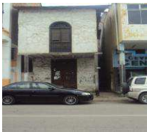
Foto antes del terremoto del 2016
