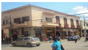
Foto antes del terremoto del 2016
