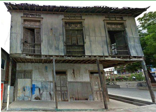
Figura 3.51.- Fachada Principal Vivienda IBI-13-09-50-000-000008 – Perteneciente a la 1era Evaluación
