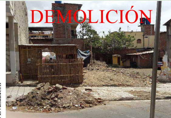
Figura 3.94.- Fachada Vivienda IBI-13-09-50-000-000012 - Perteneciente a la 2da Evaluación
