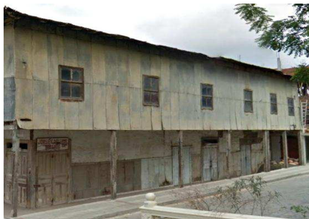
Figura 5.1.- Fachada Secundaria Vivienda IBI-13-09-50-000-000008 – Perteneciente a la 1era Evaluación
