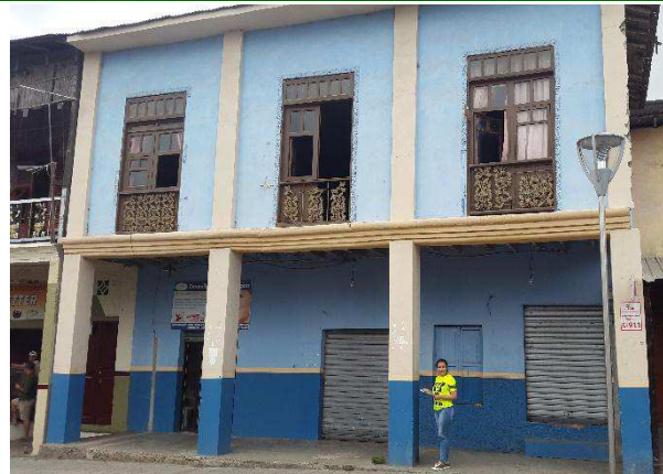
Figura 3.72.- Fachada Vivienda IBI-13-09-50-000-000010 – Perteneciente a la 1era Evaluación
