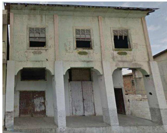
Figura 3.93.- Fachada Vivienda IBI-13-09-50-000-000012 - Perteneciente a la 1era Evaluación
