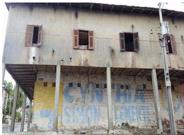
Figura 4.1.- Fachada Secundaria Vivienda IBI-13-09-50-000-000004 – Perteneciente a la 1era
