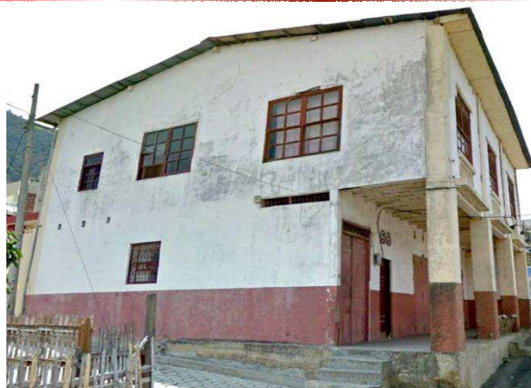
Figura 7.1.- Fachada Secundaria Vivienda IBI-13-09-50-000-000011 – Perteneciente a la 1era Evaluación
