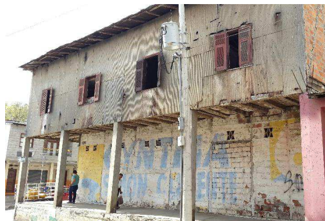
Figura 4.2.- Fachada Secundaria Vivienda IBI-13-09-50-000-000004 – Perteneciente a la 2da Evaluación
