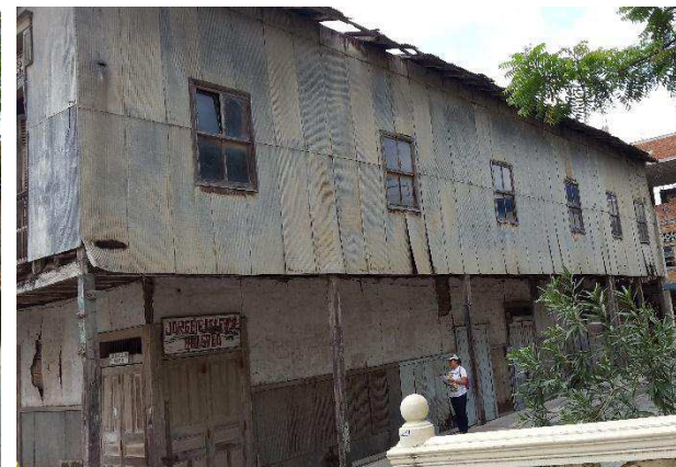
Figura 5.2.- Fachada Secundaria Vivienda IBI-13-09-50-000-000002 – Perteneciente a la 2da Evaluación
