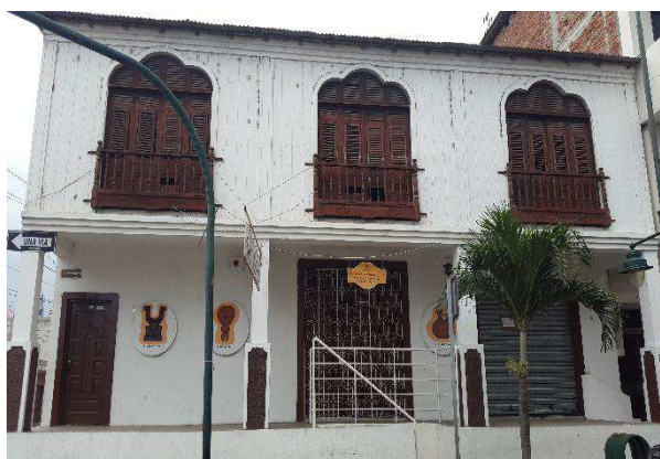
Figura 3.63. Fachada Principal Vivienda IBI-13-09-50-000-000009 – Perteneciente a la 1era Evaluación
