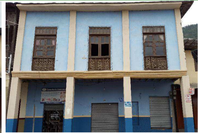
Figura 3.73.- Fachada Vivienda IBI-13-09-50-000-000010 – Perteneciente a la 2da Evaluación
