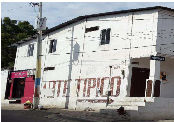
Figura 6.1.- Fachada Secundaria Vivienda IBI-13-09-50-000-000009 – Perteneciente a la 1era Evaluación
