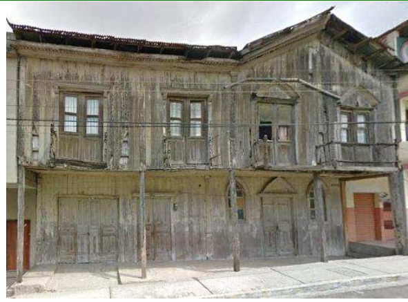
Figura 3.10.- Fachada Vivienda IBI-13-09-50-000-000002 – Perteneciente a la 1era Evaluación.
