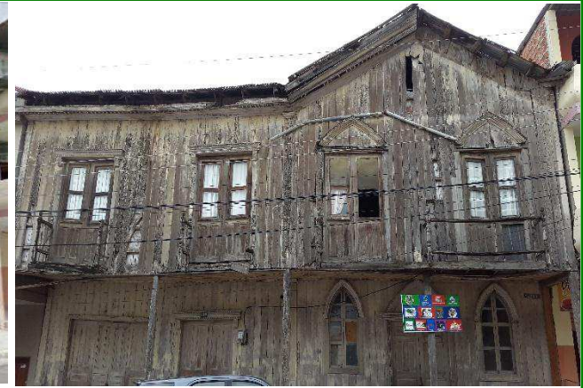
Figura 3.11.- Fachada Vivienda IBI-13-09-50-000-000002 – Perteneciente a la 2da Evaluación
