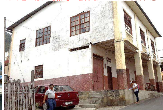
Figura 7.2.- Fachada Secundaria Vivienda IBI-13-09-50-000-000011 – Perteneciente a la 2da Evaluación
