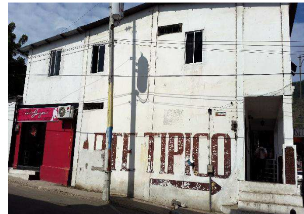
Figura 6.2.- Fachada Secundaria Vivienda IBI-13-09-50-000-000009 – Perteneciente a la 2da Evaluación
