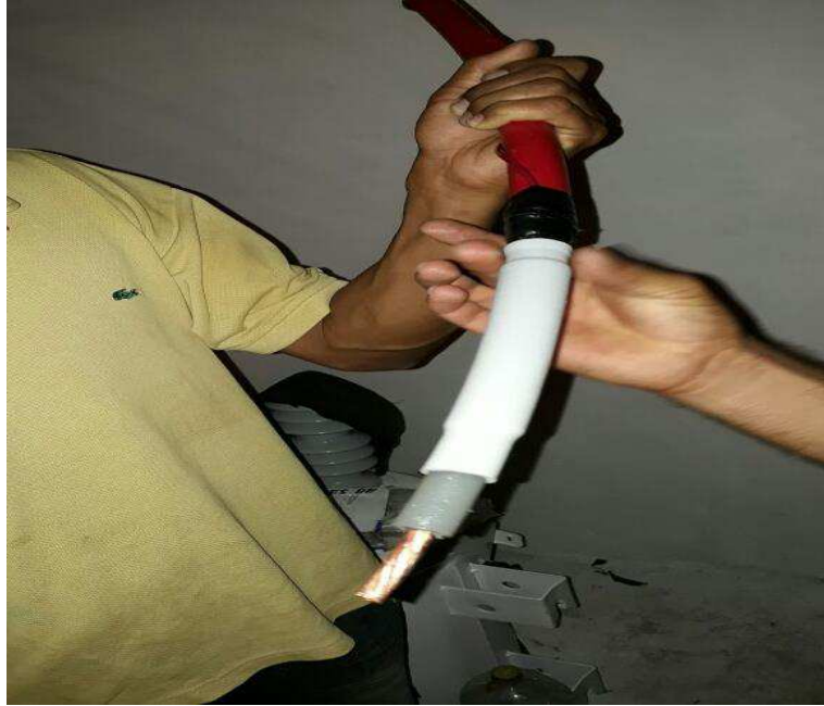
Instalando la punta terminal interior 2-4/0 AWG 15KV
