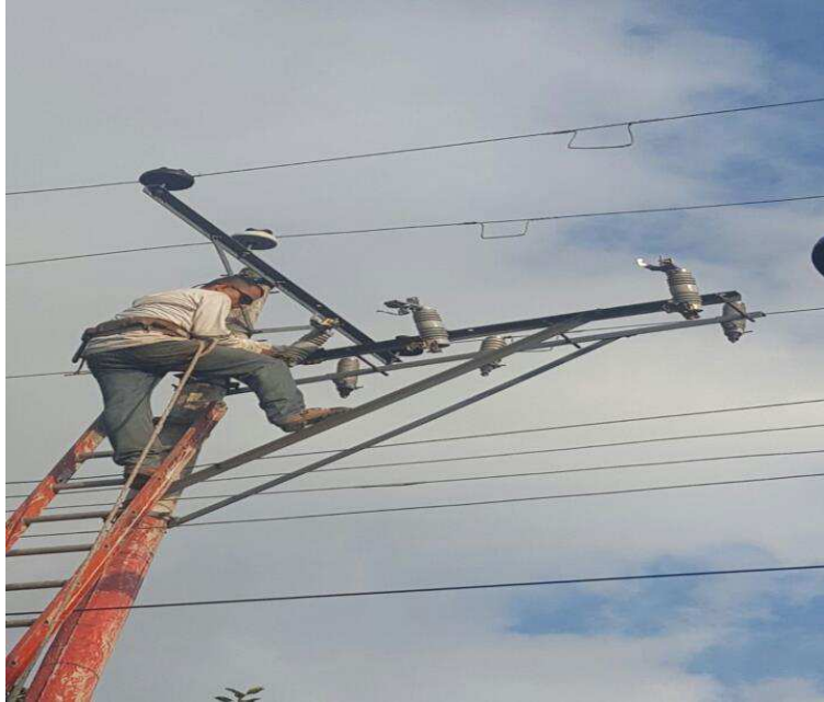
Instalando crucetas y seccionadores
