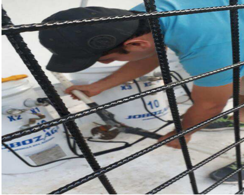
Machinando el neutro de los transformadores con la puesta a tierra.
