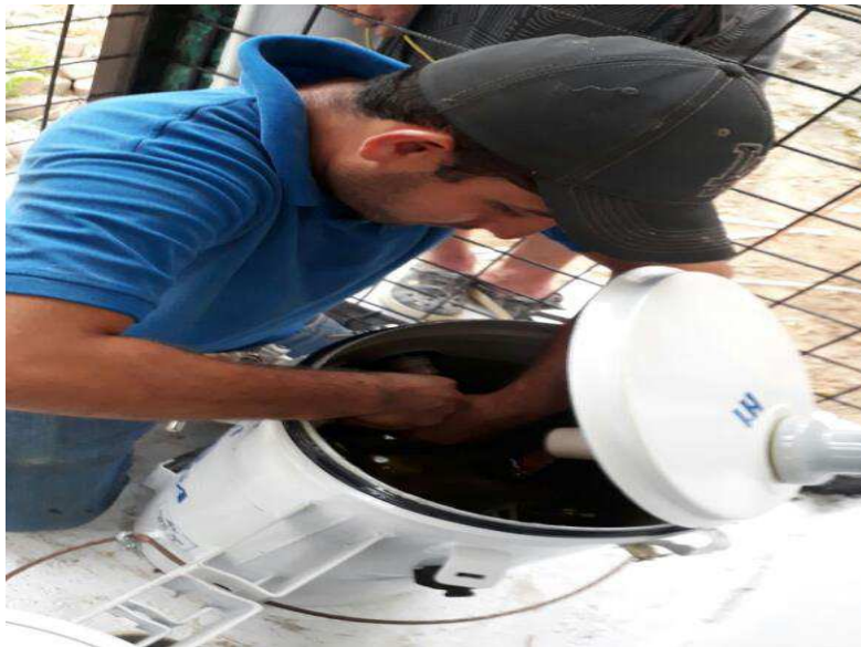
Realizando cambios de conexiones en baja tensión.
