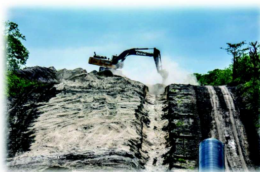
Ilustración 11 Tapado de zanja
