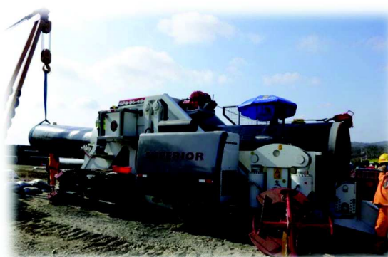
Ilustración 6 Doblado de tubería en obra
