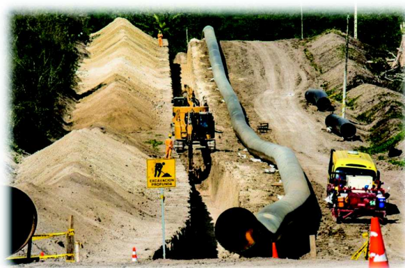
Ilustración 8 Zanjado en obra
