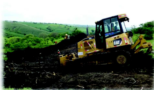
Ilustración 3 Marcación del eje de la zanja del ducto
