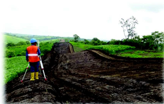
Ilustración 4 Limpieza del Derecho de Vía (DDV)
