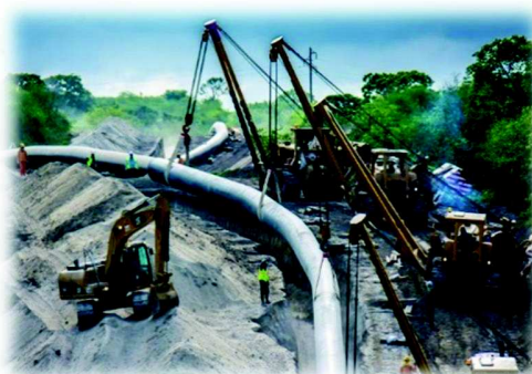
Ilustración 10 Bajado de tubería
