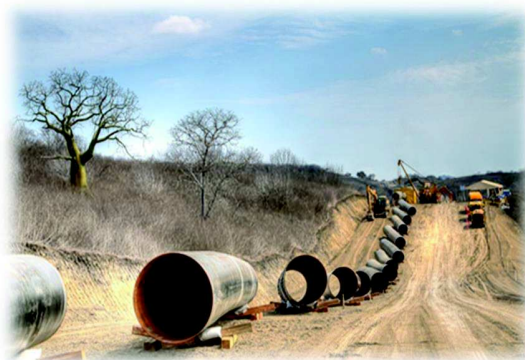
Ilustración 5 Desfile de tubería en obra
