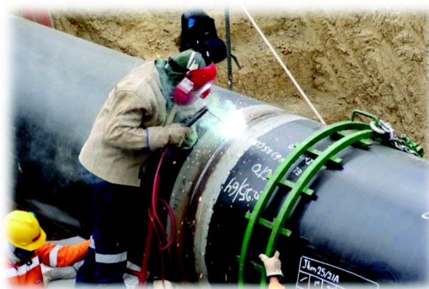
Ilustración 7 Soldadura de juntas en la obra
