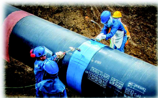
Ilustración 9 Revestimiento de juntas
