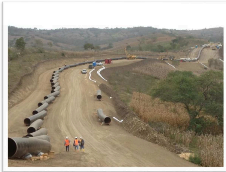
Imagen5 Tuberías rectas que forman el acueducto, (Gamboa&Asociados)
