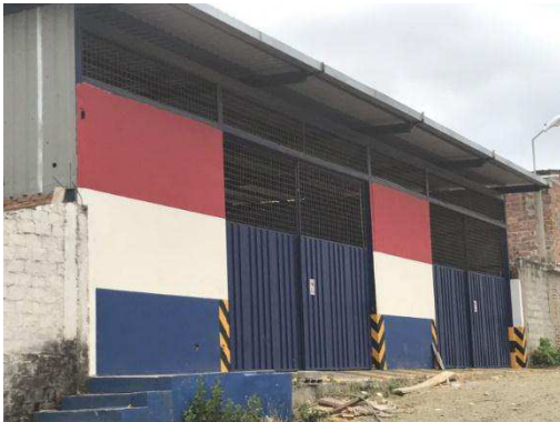
Foto 18. Área de GLP
