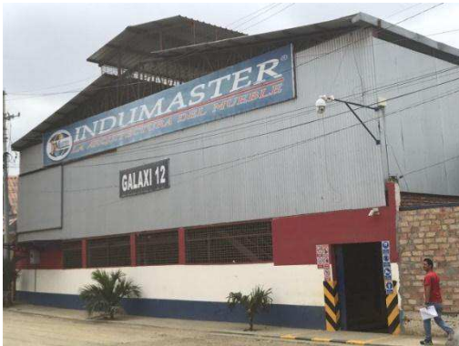
Foto 14. Taller o área de tableros
