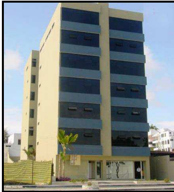
Edificio El Navío
