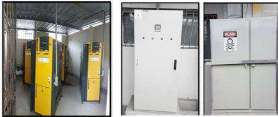
Figura 16. Compresor, Instalaciones eléctricas
