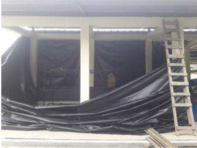
Foto 1: Cerramiento de la infraestructura con geomembrana para la producción de FVH
