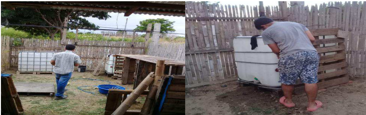
Anexo 6: Construcción del sistema de protección e instalación del sistema de recirculación
