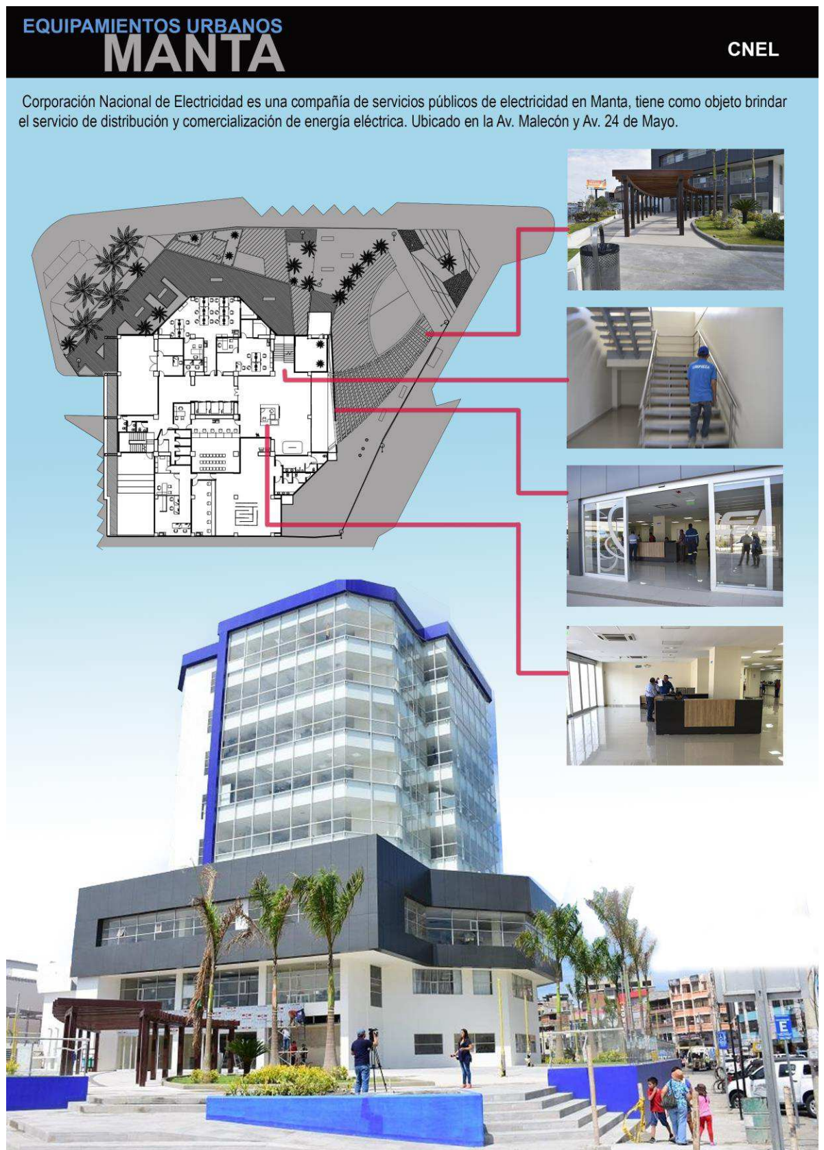
Ilustración 21 CNEL Fuente: Tesista
