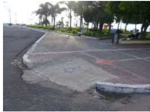
Ilustración 59: Rampa existente ubicada en la Vía 3 Fuente: Investigador
