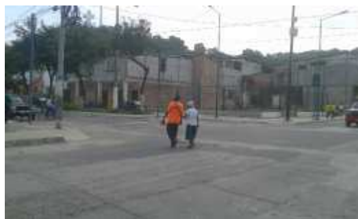
Ilustración 63: Inexistencia de señalización o infraestructura Vía 2 Fuente: Investigador
