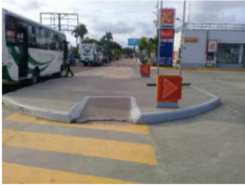
Ilustración 60: Rampa existente ubicada en la vía 1 Fuente: Investigador
