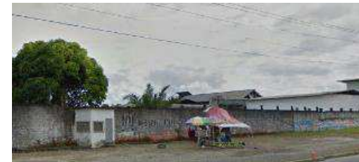
Ilustración 103: Fachada general del local año 2015, elaboración propia.
