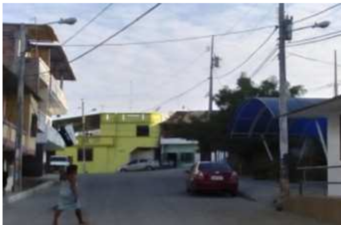
Foto. Energía eléctrica en la playa de San Mateo.
