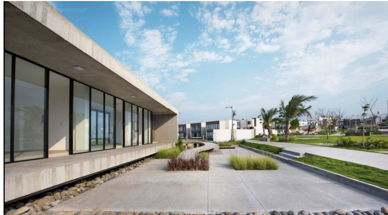
ILUSTRACION 11: Alika residencial FUENTE: Plataforma Arquitectura
