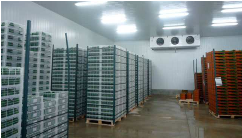
Figura N° 20: Cámara de Frio
