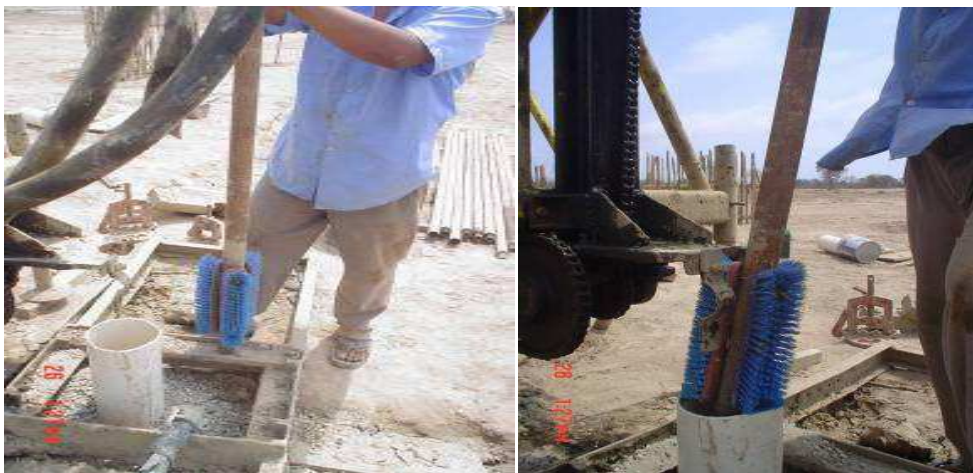
Grafico 24: Filtros que evitan ingresen residuos Fuente: Terreno Los Bajos-Montecristi Realizado por: Victoria Pillasagua
