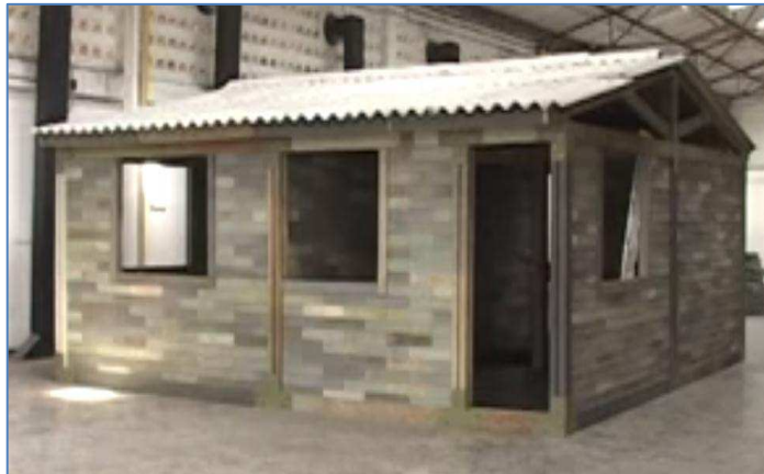
Figura # 1.28: Casa tipo construida a partir de bloques plásticos
