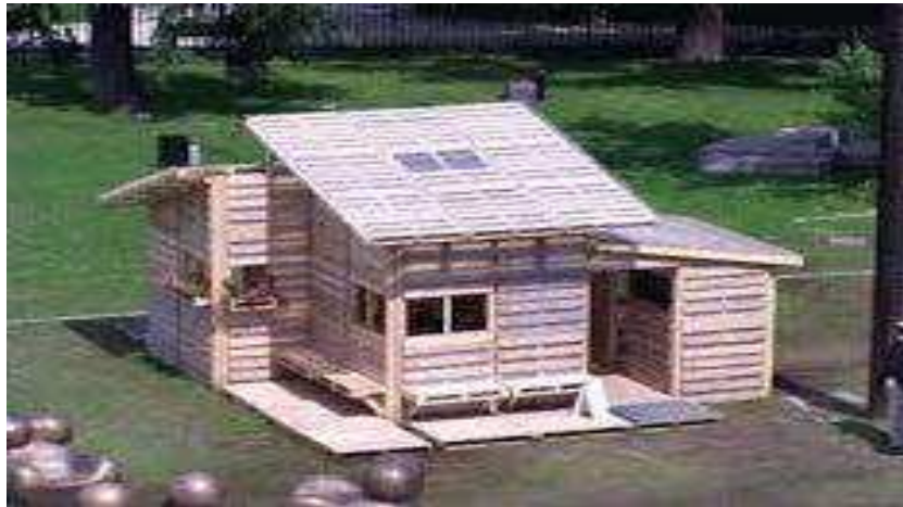
Figura # 4.52: Vivienda de pallets
