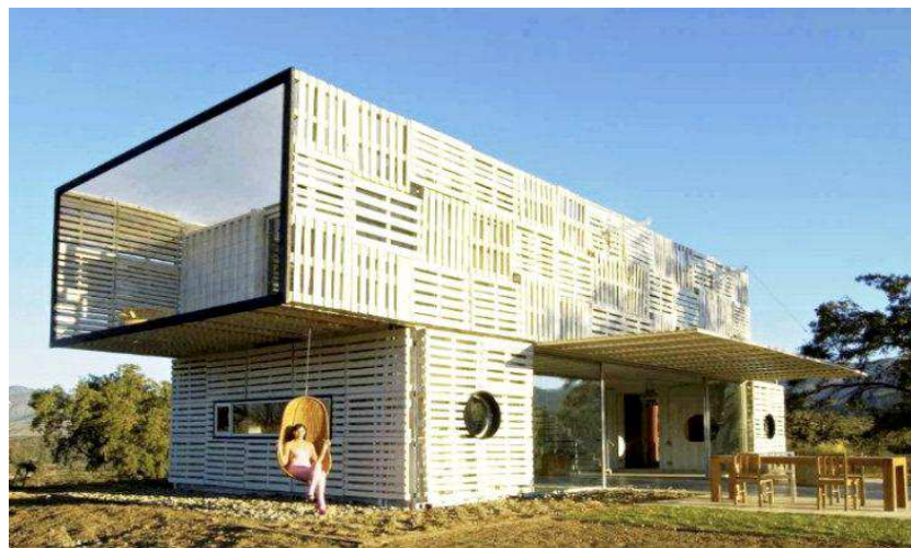
Figura # 4.53: Vivienda de pallets
