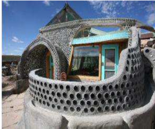
Figura # 1.25: Construcción de tierra con botellas.
