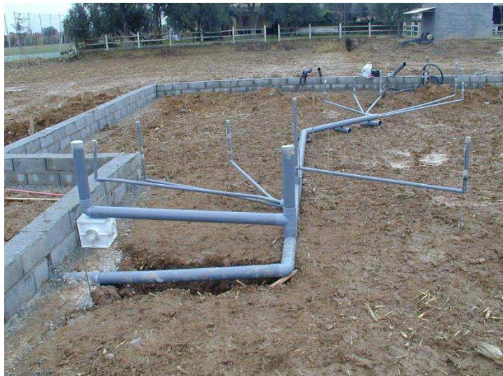
Figura # 2.32: Colocación de tubería de pvc
