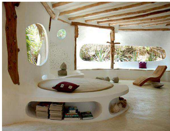
Figura # 1.24: Acabado interior de una vivienda realizada en cob.
