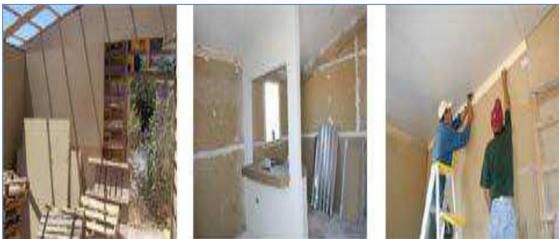
Figura # 2.42: Revestimiento y preparación de paredes
