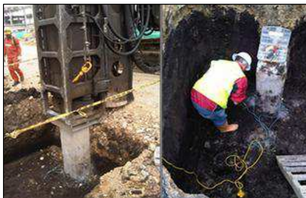
Figura 1.8 Prueba de carga dinámica. (Fuente: http://jeoprobe.com/servicio_pilotes_pda.html )
