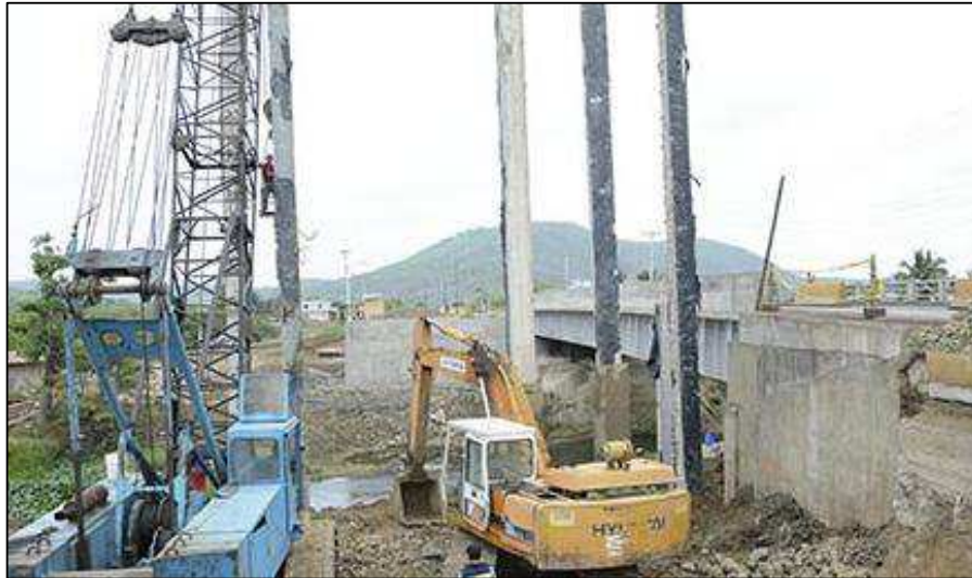
Figura 2.7 Hincia de Pilotes en Puente Mejía. Fuente: Diario La Hora
