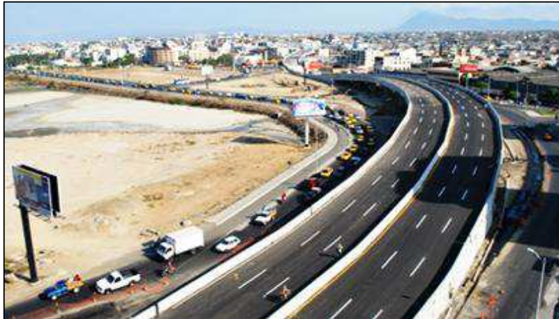
Figura 2.2 Intercambiador de Tránsito Manta. Fuente: Ministerio de Transporte y Obras Públicas
