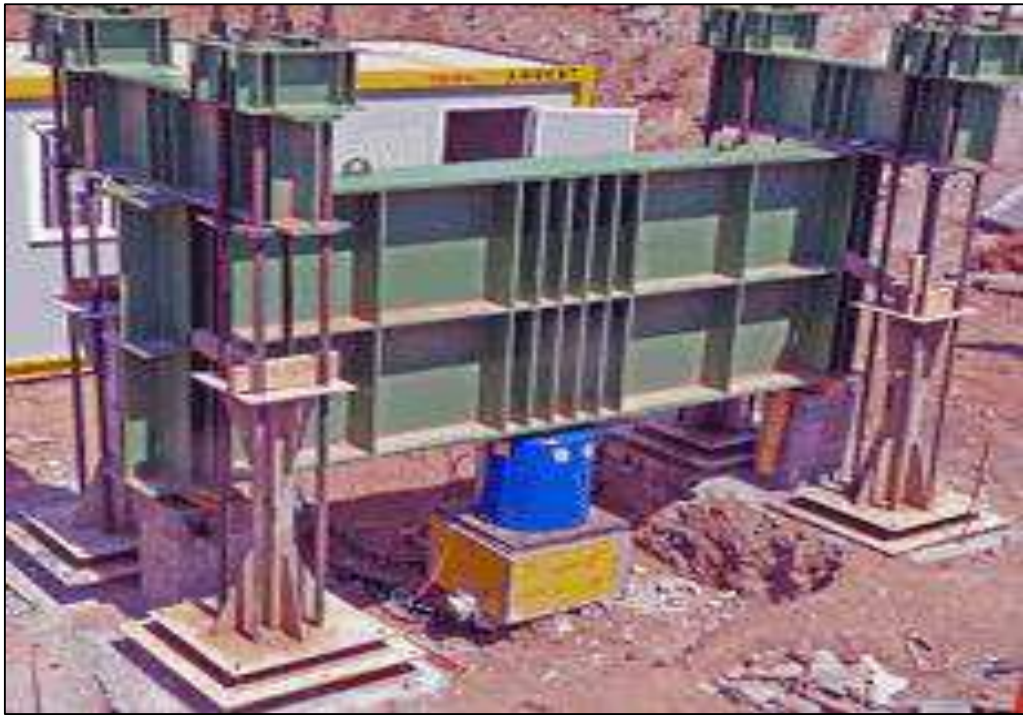
Figura 1.6 Prueba de carga estática. (Fuente: http://ripollconsulting.com/pilotes.h0tml )
