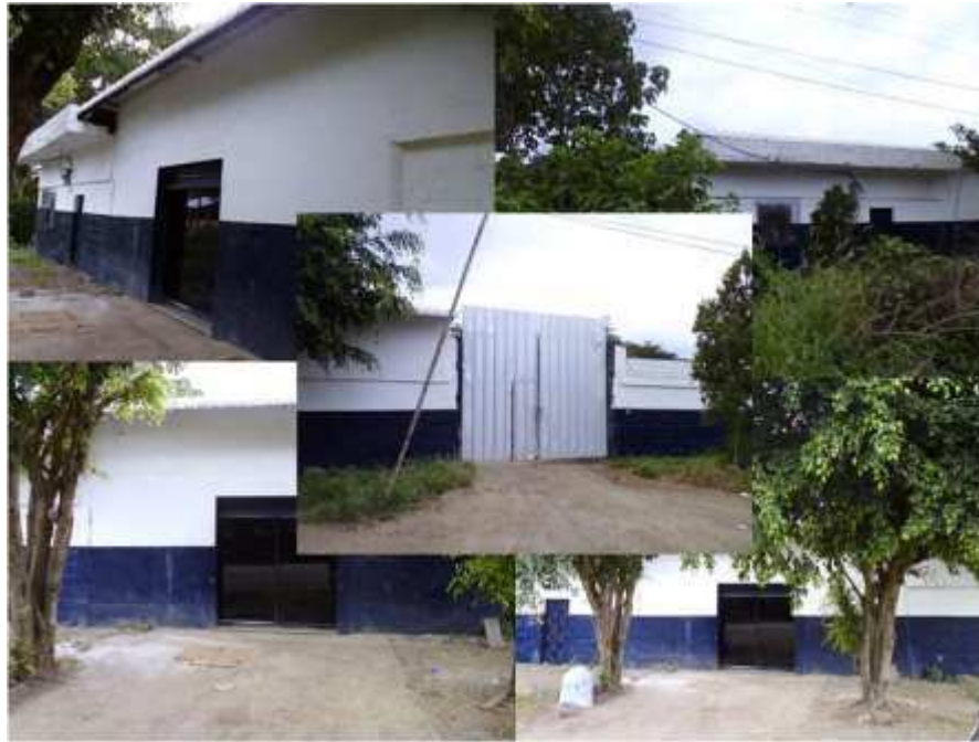
Instalaciones Planta Clean Water
