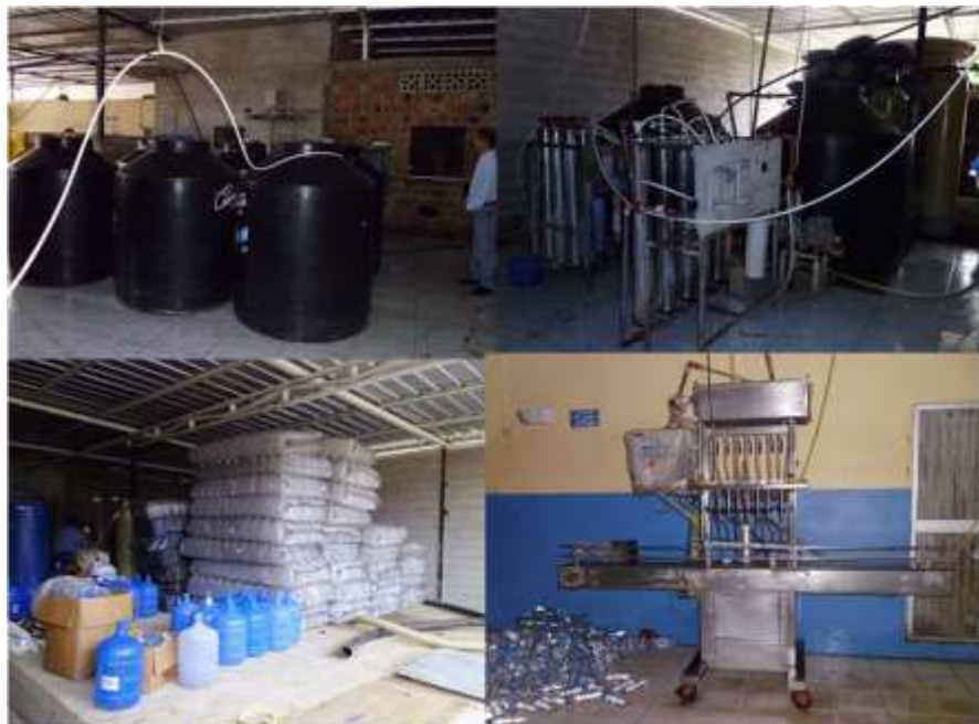
Área de Maquinarias y Recepción de Materiales
