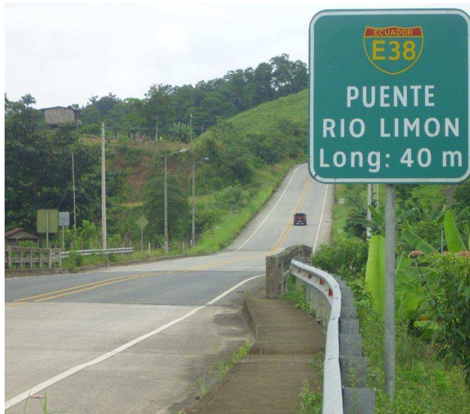
Imagen 6. Contracción de la vía al puente antiguo Elaboración: Los Autores
