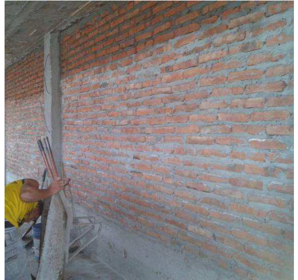
Paredes construidas con ladrillo burrito
