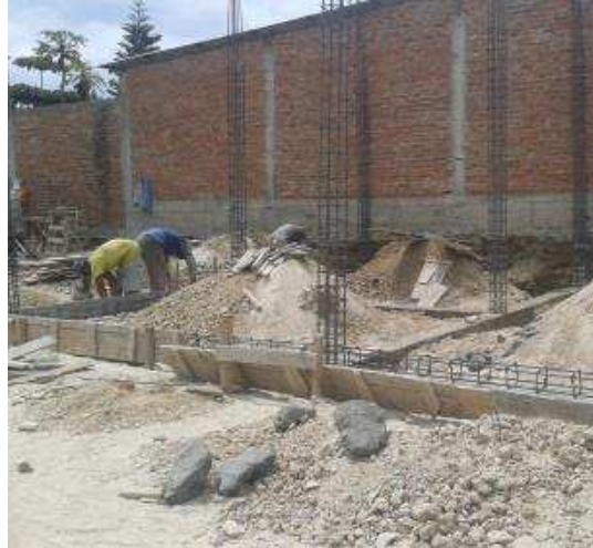
Colocan encofrado de madera para fundir cadenas
