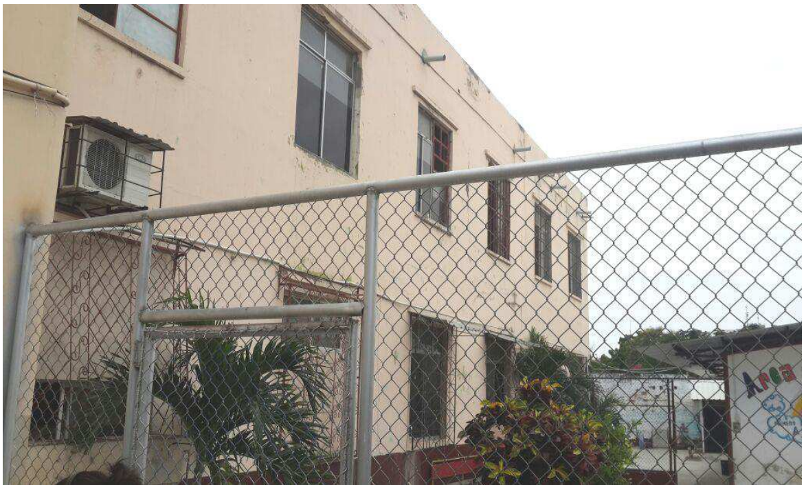
Figura 30: Vista lateral del bloque 1 de la Unidad Educativa Pedro Fermín Cevallos
