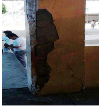
Figura N° 10. Espaciamiento de refuerzo trasversal Fuente: Los Autores
