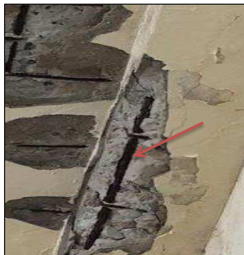
Figura N° 2. Acero liso de la estructura Fuente: Los Autores
