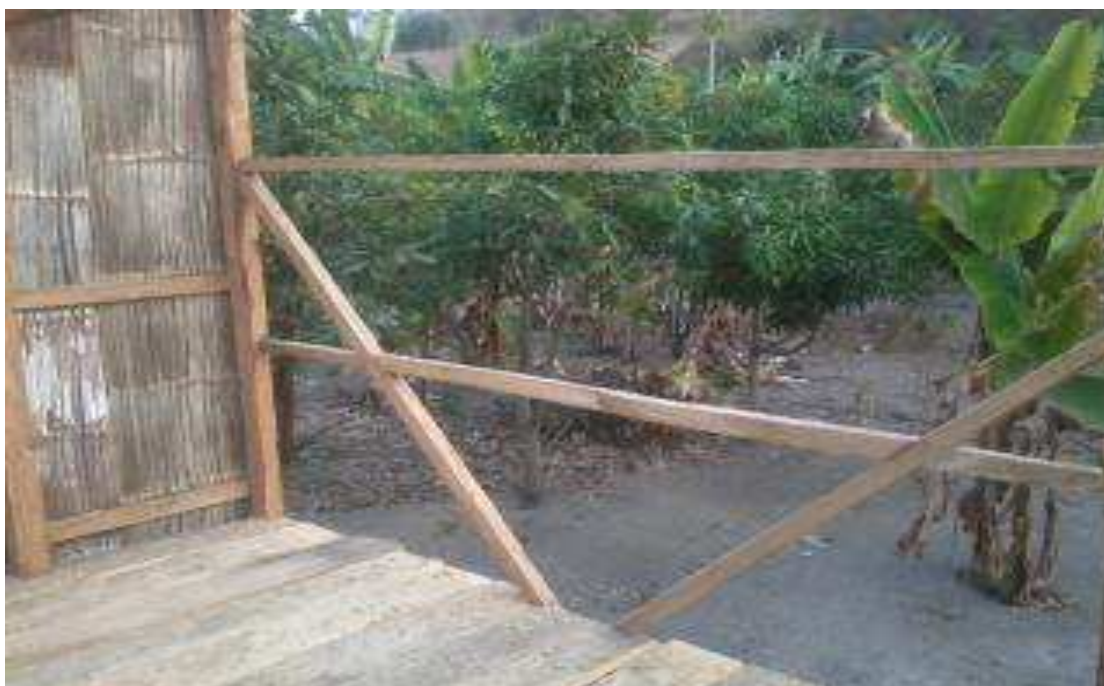
Muestra cómo están ubicados los travesaños de espigas a espigas. Elaborado por: Los Autores.
