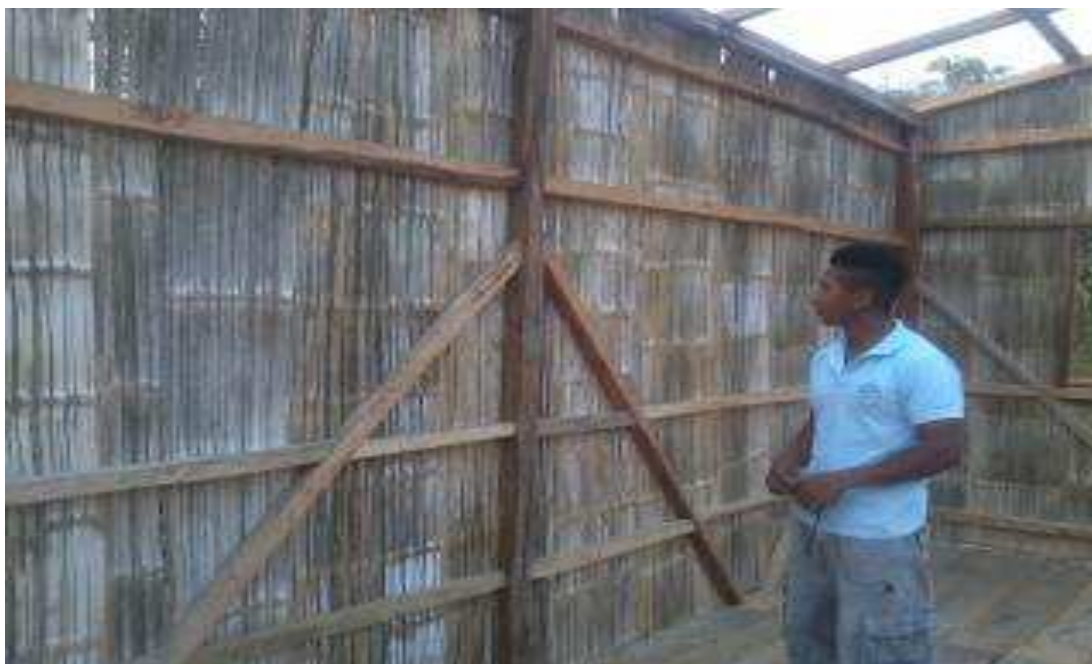
Pared de estructura de madera y caña, una vez terminada.
