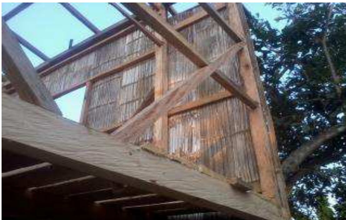
Cortes utilizados en la colocación de espigas para que dé mayor dureza a la estructura.
