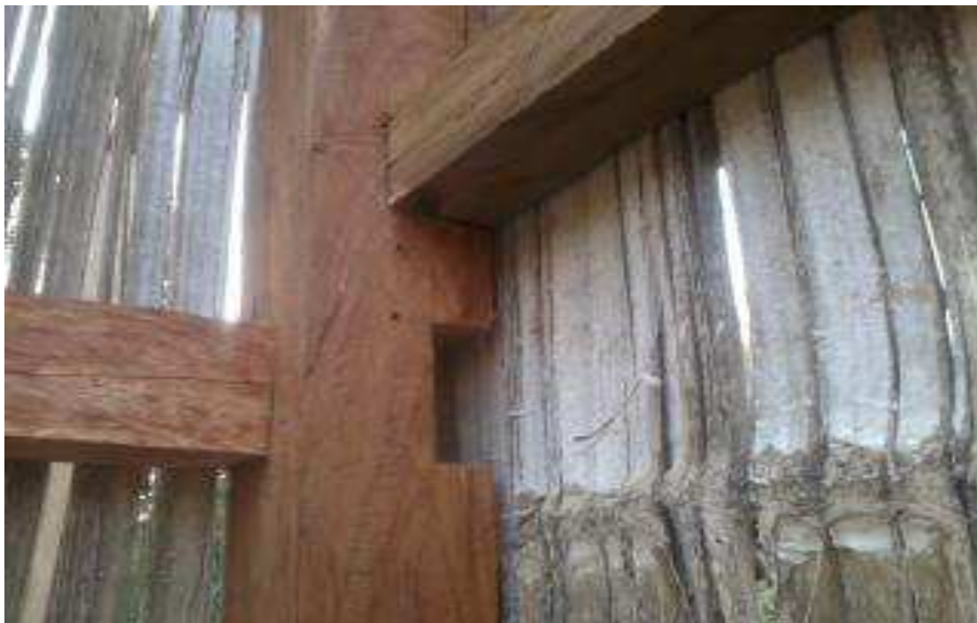
Cortes en viviendas de maderas, en la parte de las espigas y travesaños. Elaborado por: Los Autores.
