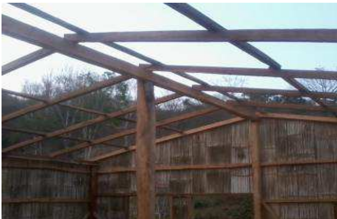
Estructura de madera listo para la colocación del techo.
