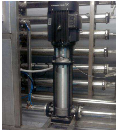
Bomba centrifuga tipo vertical
