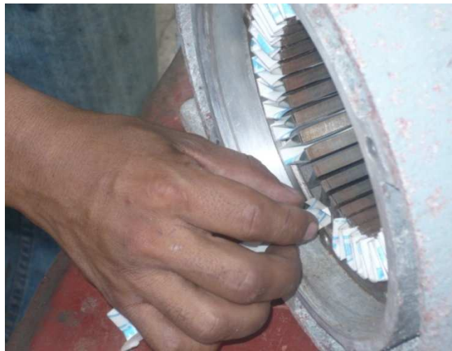
Figura 25. Colocación de aislante en las ranuras
