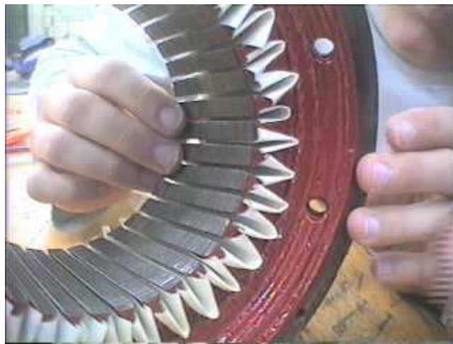
Figura 26. Colocación de aislante en las ranuras
