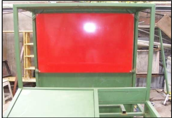
Figura 4-13: Construcción del plafón de la consola.
