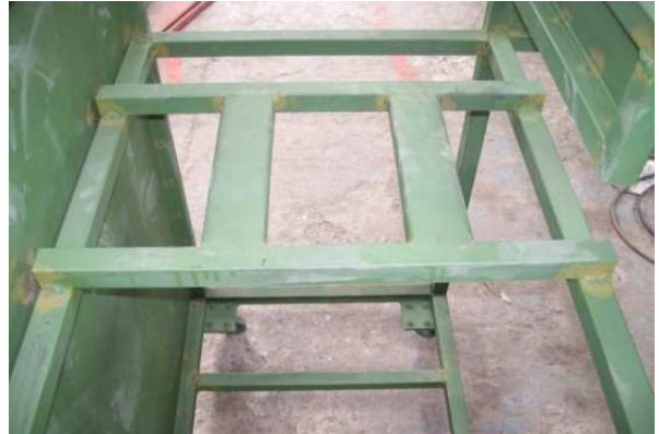
Figura 4-12: Construcción de la bancada del motor
