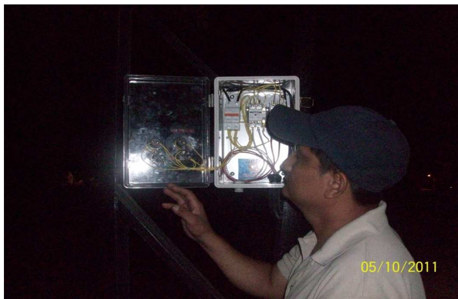
Ubicando el tablero y probando los selectores y luces pilotos.
