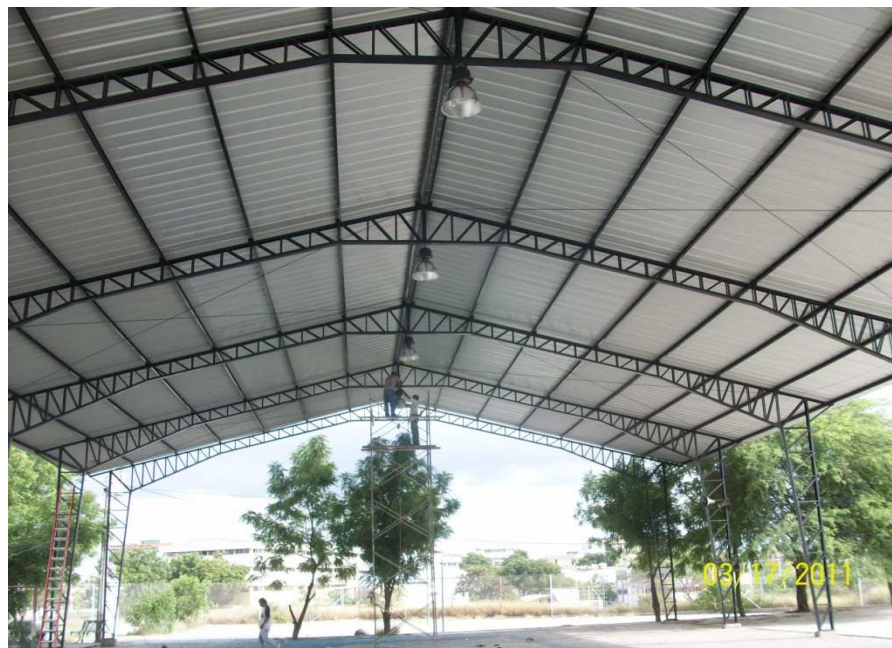
Instalación de lámparas a 8 metros de altura.
