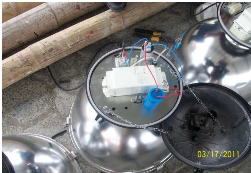
Se abrió la lámpara para colocar el cable concéntrico en los bornes de salida
