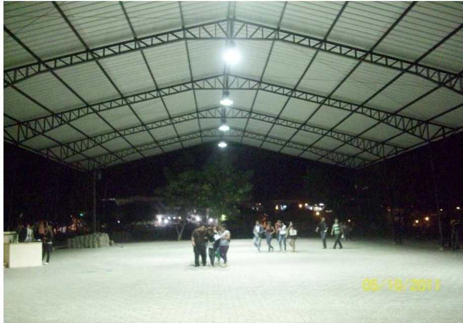
Área iluminada en la noche.
