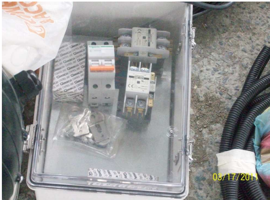
Armamos el tablero de control de luminarias
