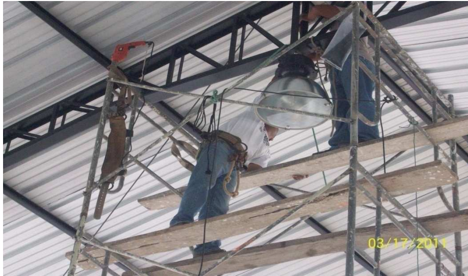
Taladramos para ubicar los ganchos que sujetan las luminarias.
