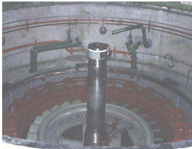
Figura 1.8. Devanados del estator del generador principal
