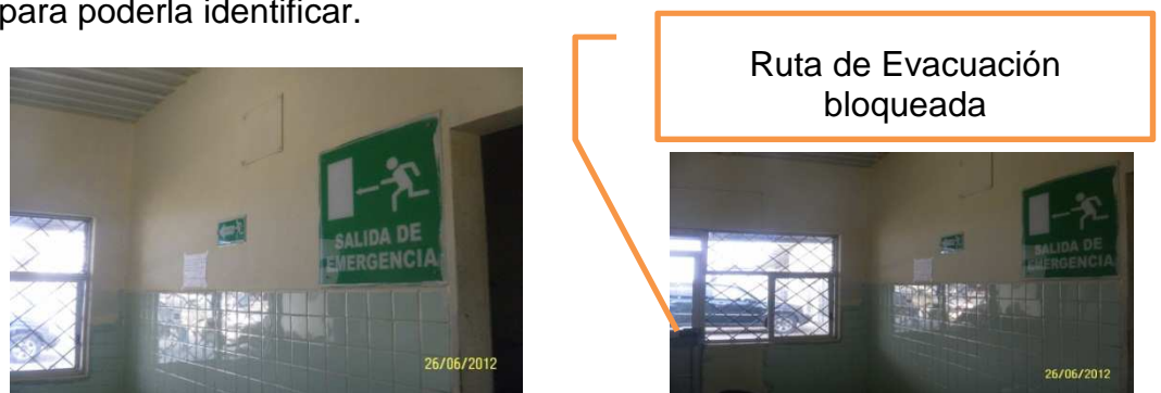
Ilustración 13 Señalización de Seguridad
