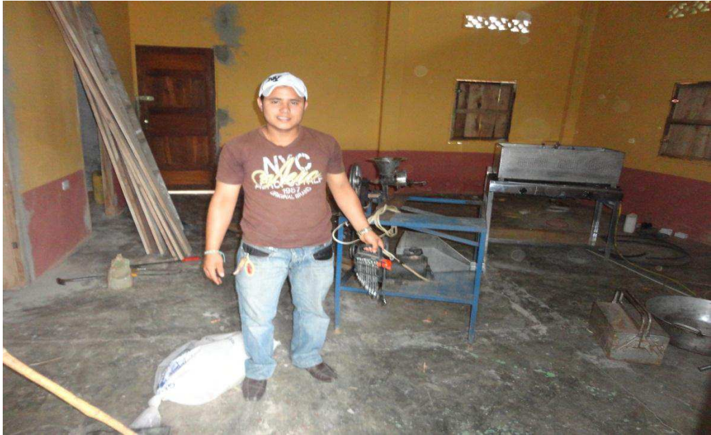
Instalando los equipos con un colaborador de la empresa
