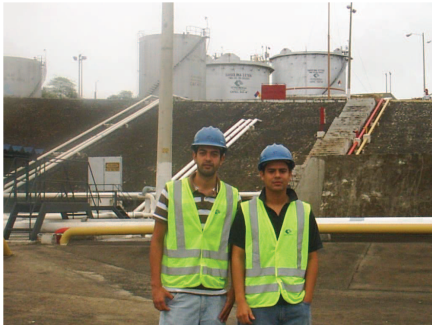
Anexo 4. Terminal de Abastecimiento en Petroecuador Barbasquillo
