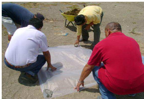
Ilustración 28 Colocación de plástico
