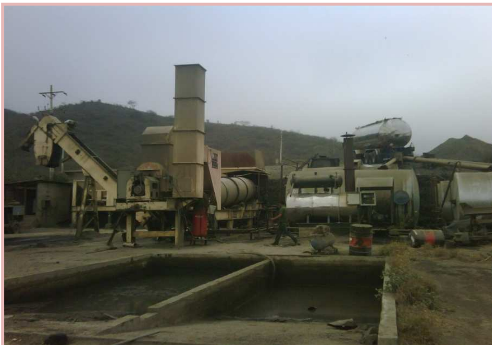
Fotografía #1 muestra la contaminación que se ha producido en el suelo
