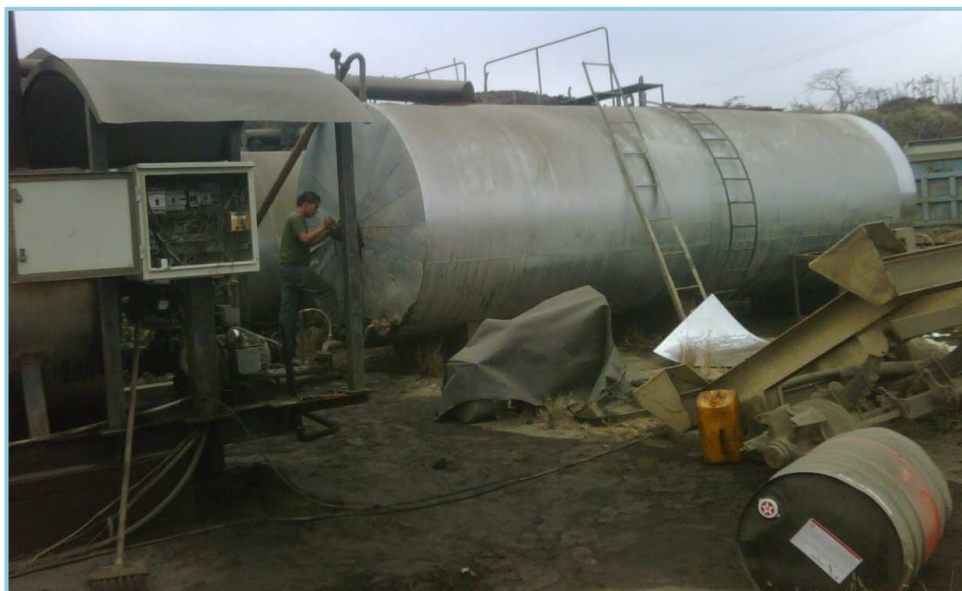
Fotografía #5. Desechos sólidos (tanques, metales, plásticos) obstaculizan la planta de asfalto
