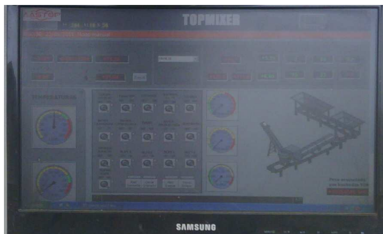
Fotografía #10 muestra el sistema automatizado de la planta.
