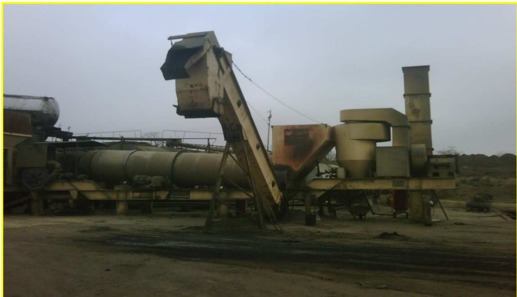
Fotografía #3. Muestra la contaminación que se ha producido en el suelo
