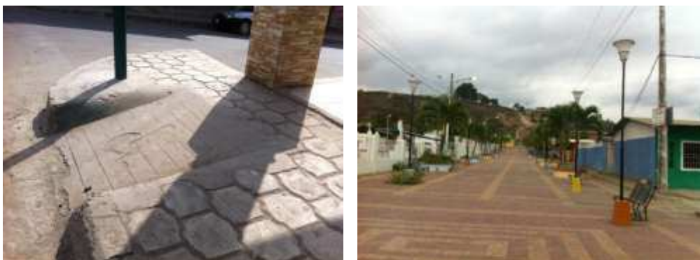
Ilustración 7: Rampas / Infraestructura peatonal Eje 51 frente al Cementerio de Rocafuerte
