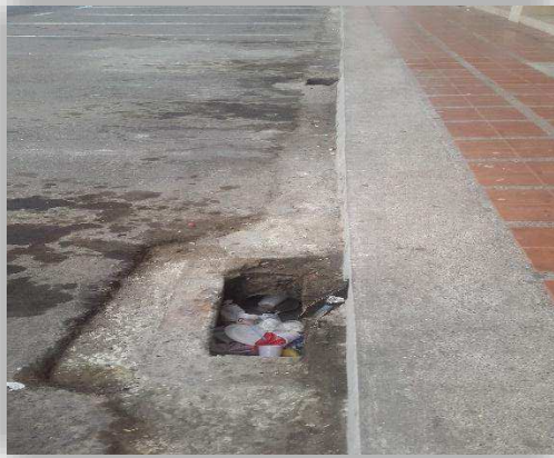
Ilustración # 14: Sistema de Agua Potable. Investigación de Campo: Egdo. Adil Cedeño Vera.
