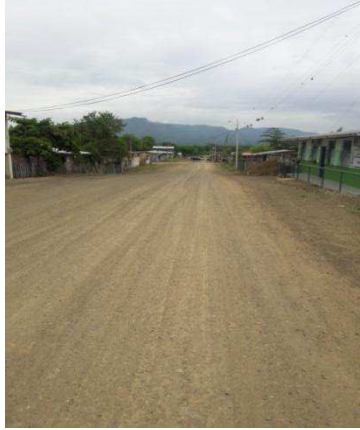
Figura 17. Vía residencial. Fotografía: Javier Parrales lucio
