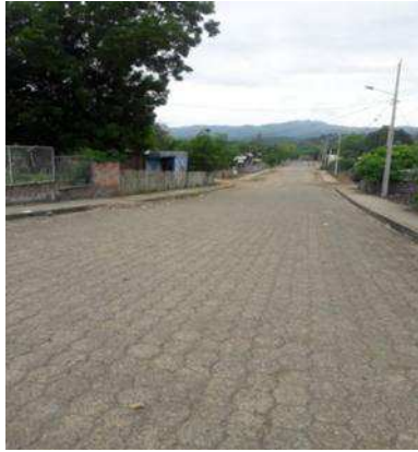
Figura 17. Vía colectora Jumber Madrid. Fotografía: Javier Parrales Lucio
